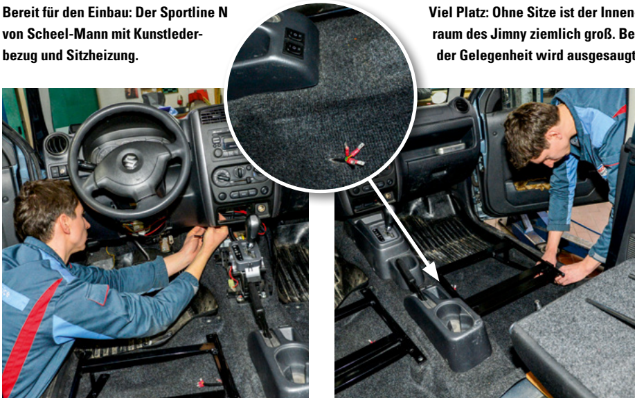
Stromzufuhr: Die Sitzheizungs-Schalter werden in die Handbrems-Konsole eingebaut (kleines Bild), das Kabel zum Sicherungskasten geführt.
